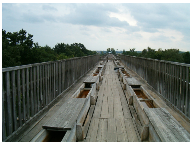
Fot. 4. Kanały doprowadzające solankę na szczyt tężni (fot. A. Szmidt)
