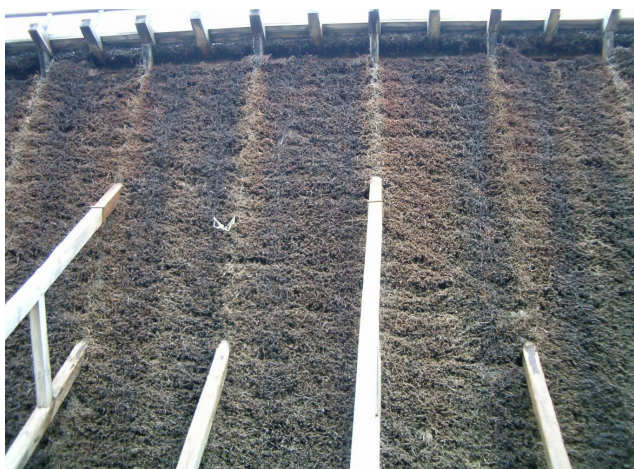
Fot. 3. Tarnina w ścianie tężni (fot. A. Szmidt)
