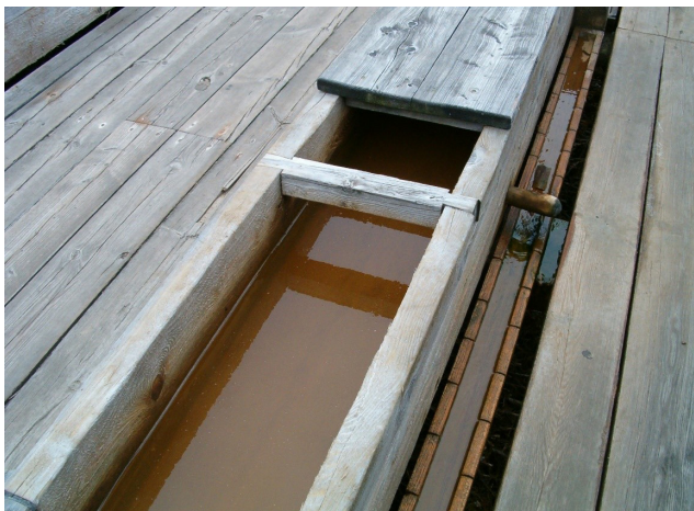
Fot. 5. Solanka, która spłynie na tarninę w tężni (fot. A. Szmidt)
