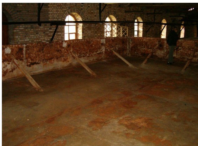
Fot. 8. Zbiornik na solankę w warzelni (fot. A. Szmidt)
