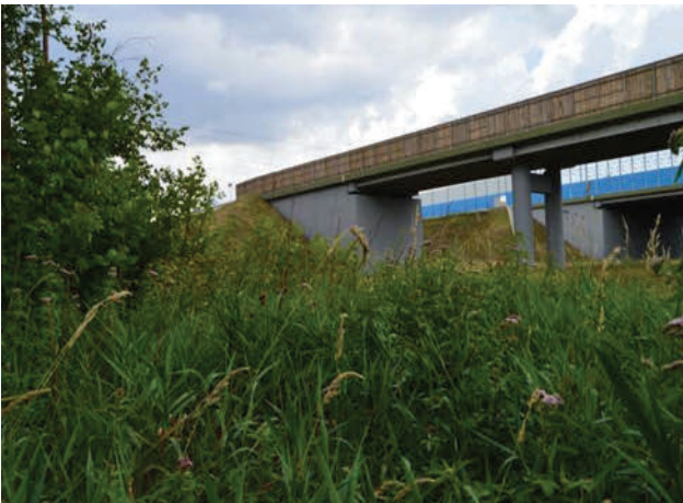
Fot. 3. Autostrada A2 (fot. Mirowska 2014)
