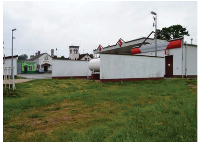
Fot. 4. Stacja paliw w Kołacinie (fot. Mirowska 2014)
