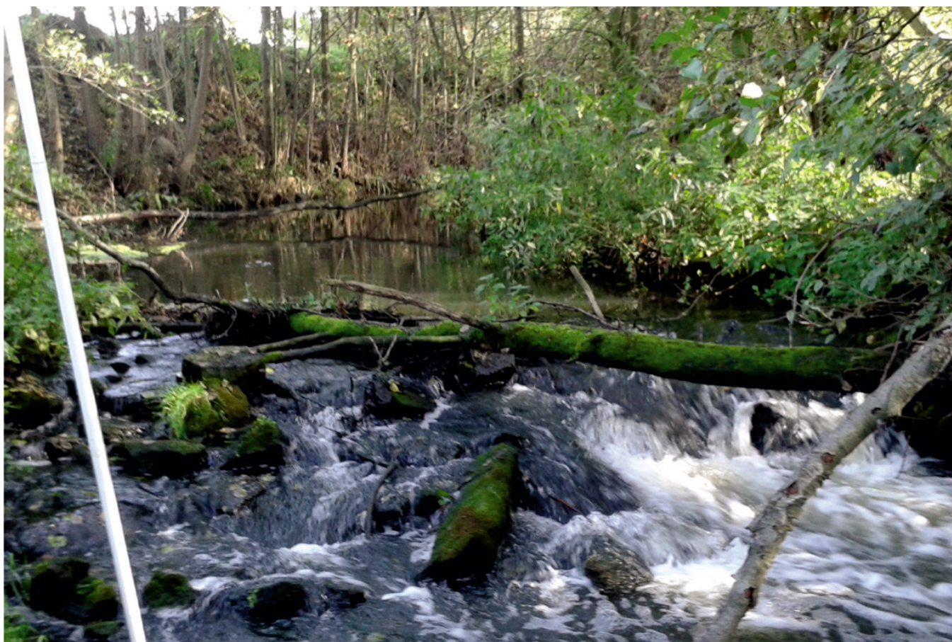
Fot. 3. Poprzeczna budowla piętrząca we wsi Gadka Stara (fot. J. Szymkiewicz)
