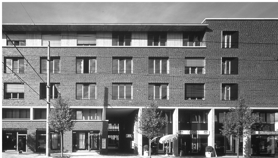
Rysunek 7. Usługi zlokalizowane w parterze budynku od strony ulicy Gebrüder Schmidt Route, fot. Roland Halbe
