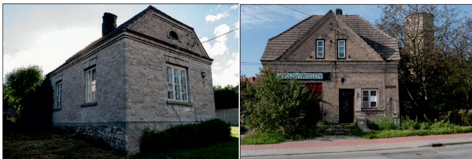
Fot. 2–3. Pozostałości Kolonii Robotniczej w Ostrowcu Świętokrzyskim
