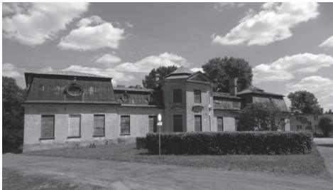
Fot. 3. Pałac Rzewuskich w Bratoszewicach – front
