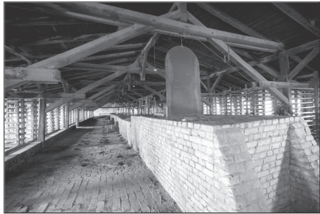
Fot. 4. Cegielnia w miejscowości Pudliszki, widok na górną część pieca (typ: piec typu „Hoffman”, widoczne są na zdjęciu czeluście zasypowe paliwa, „koniki” i właz umożliwiający regulację napływu powietrza, w tle konstrukcje umożliwiające suszenie cegieł)
