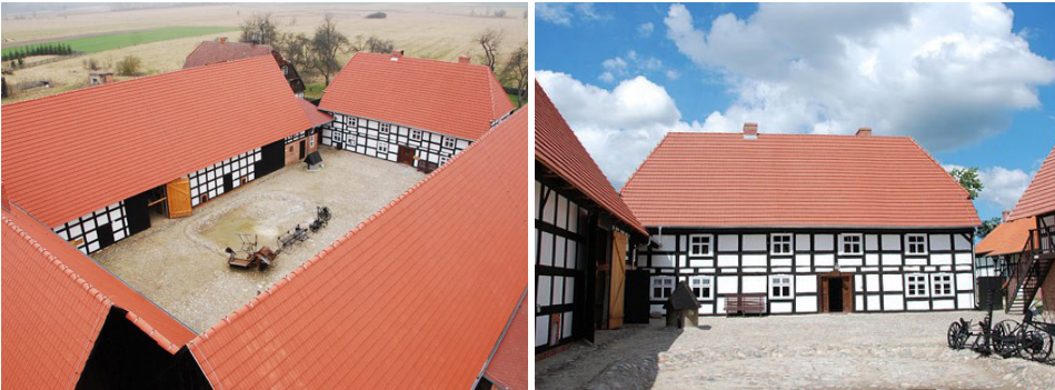
Fot. 1. Układ budynków zrekonstruowanej Zagrody Albrechta (nr 8)
