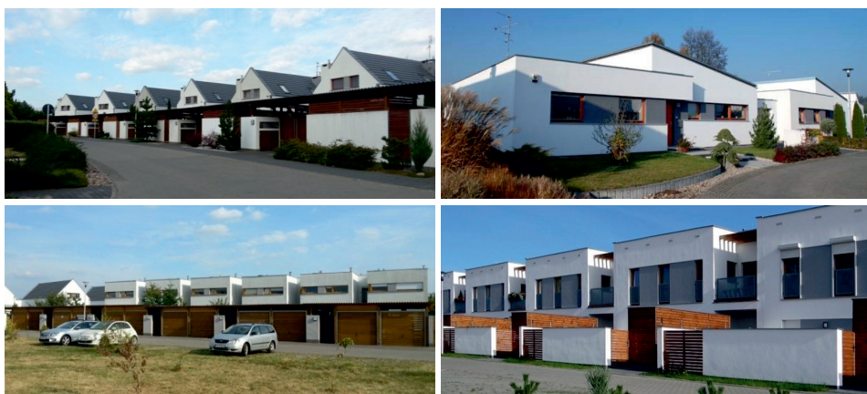
Ryc. 4. Leśna Osada, Dąbrówka – zabudowa mieszkaniowa jednorodzinna fot. M. Szczepańska
