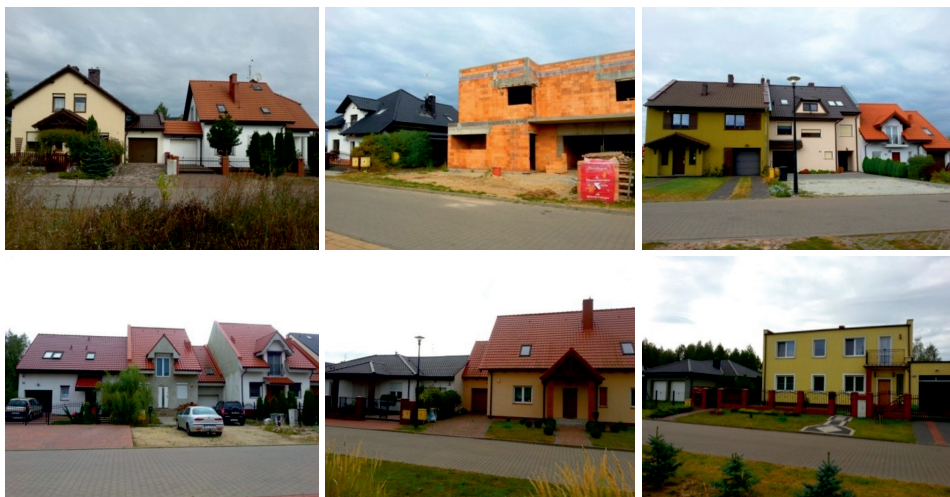
Ryc. 3. Osiedle Ptasie, Przeźmierowo – zabudowa mieszkaniowa jednorodzinna fot. M. Szczepańska
