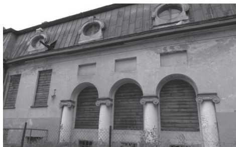
Fot. 8. Pałac Rzewuskich w Bratoszewicach – dach mansardowy z lukarnami fot. A. Rochmińska (2017)
