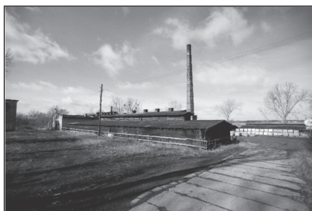
Fot. 1. Cegielnia w miejscowości Pudliszki, widok na centralnie usytuowany piec wraz z budynkami funkcjonalnymi
