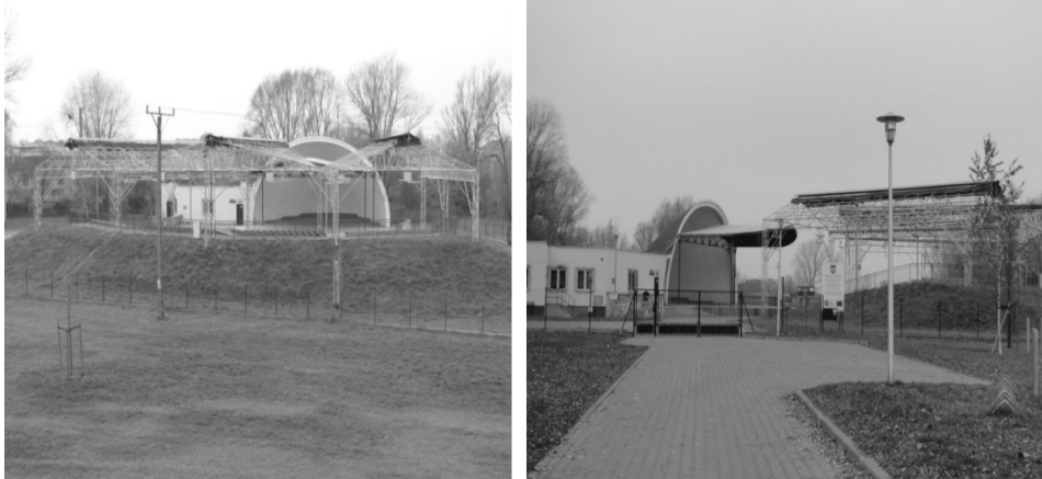
Fot. 2–3. Muszla koncertowa w Parku Błonie po dokonaniu modernizacji
