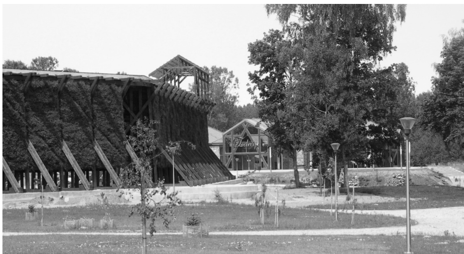
Fot. 1. Tężnie i pijalnia wód w parku zdrojowym
