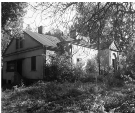
Fot. 12. Dwór w Kobylnikach – pustostan fot. A. Kubiak (2006)
