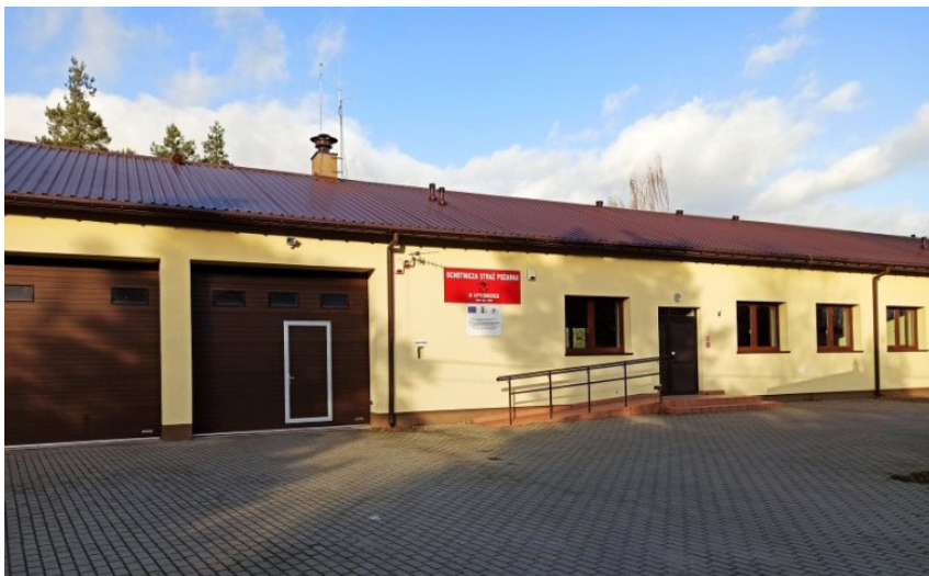
Ryc. 21. Budynek Ochotniczej Straży Pożarnej w Spycimierzu
