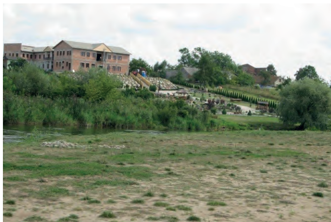
Ryc. 5. Zbocze doliny Warty łagodzone podczas prac budowlanych (fot. E. Kobjek, 2016)
