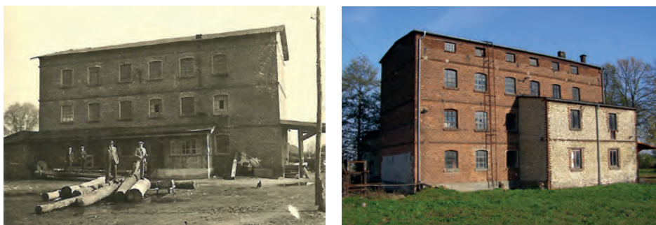
Ryc. 7. Młyn braci Pelc w Wilamowie. Po lewej – stan przed 1943 r. Po prawej – stan obecny, 27.10.2014 r. Widok od strony zachodniej, po lewej stronie widoczny tartak / trak tartaczny Źródło: archiwum prywatne Zofii Orłowskiej (fot. archiwalne) i fot. F. Tomaszewski, 2014
