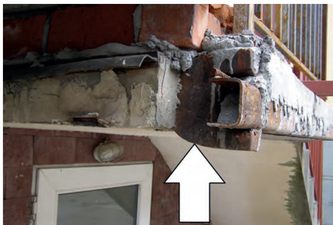
Ryc. 6. Metalowy wał napędzający górny kamień młyński (tzw. „socha”), pochodzący z wiatraka Antoniego Kamińskiego, wmurowany w konstrukcję domu przy ul. Spacerowej 7 w Uniejowie
