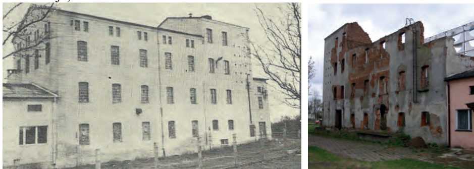
Ryc. 1. Młyn braci Wojciechowskich przy ul. Bł. Bogumiła w Uniejowie. Po lewej – stan przed pożarem w 1981 r. (strona południowa), po prawej – stan obecny, 14.04.2017 r. (elewacja północna, widok od strony podwórza)
