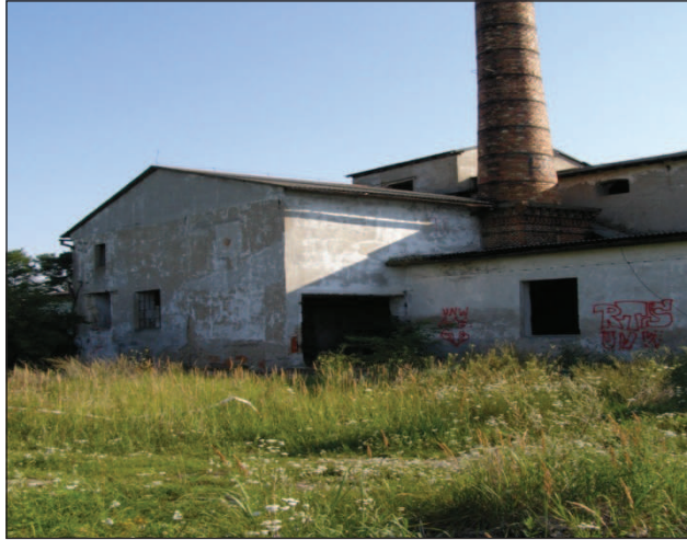
Fot. 4. Ruiny budynku gorzelni Czepów-Stanisławów Źródło: fot. G. Myszkorowska-Olczyk, 2012
