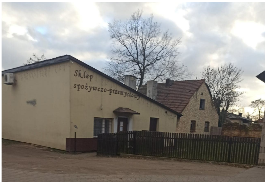
Ryc. 22. Budynek jednego ze sklepów w Spycimierzu
