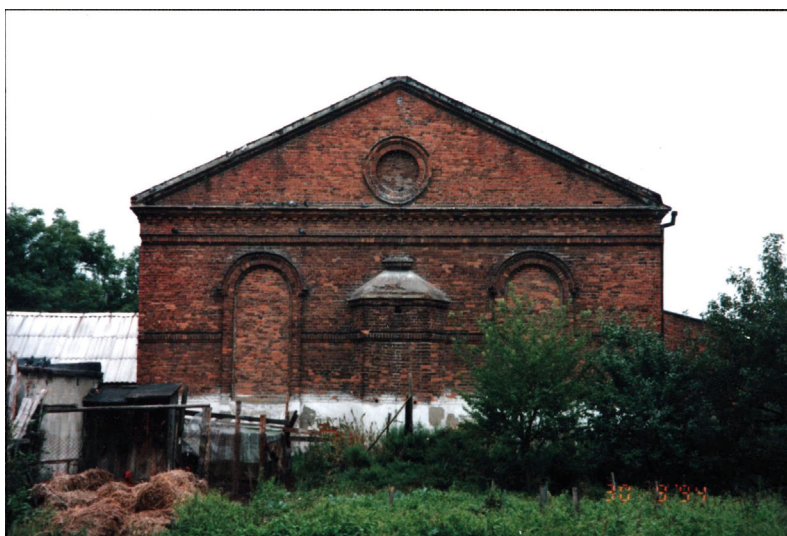
Fot. 14. Ściana wschodnia szadkowskiej synagogi z niewielką trójbocznie zamkniętą absydą, 1994 r. Absyda mieściła dawniej Aron ha-kodesz (drewnianą lub kamienną szafę ołtarzową do przechowywania zwojów Tory)
