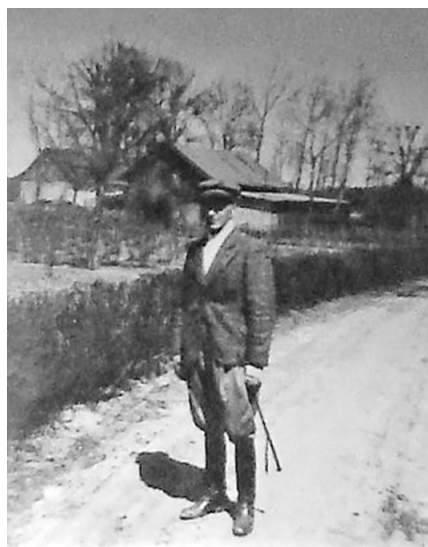
Fot. 12. Nierozpoznana osoba, w tle widoczne zabudowania wsi Przatów, ok. 1914
