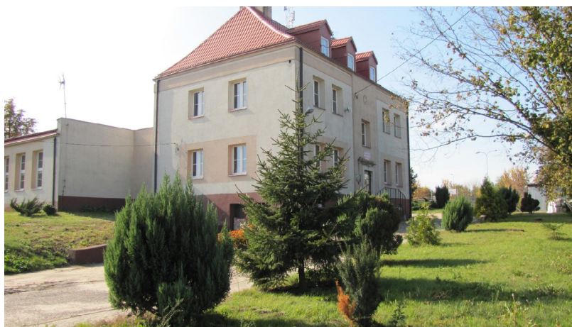
Fot. 11. Obiekt Miejsko-Gminnego Ośrodka Kultury oraz posterunku policji Źródło: fotografia własna, wrzesień 2018
