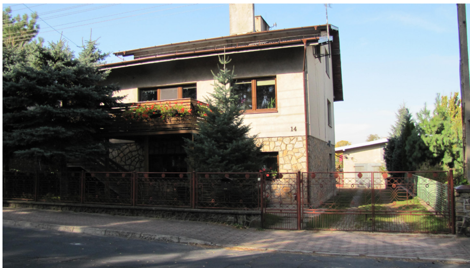
Fot. 10. Przykład budynku mieszkalnego z użytkowym poddaszem i podpiwniczeniem przy ul. Spacerowej
