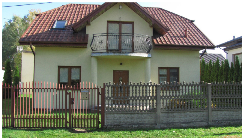
Fot. 6. Typowy budynek z poddaszem użytkowym Źródło: fotografia własna, wrzesień 2018
