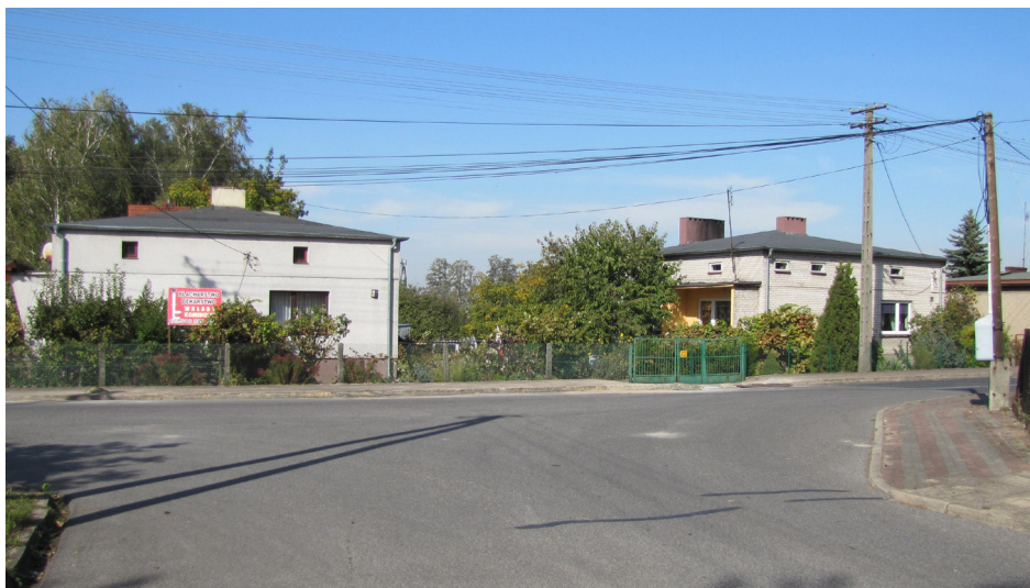
Fot. 8. Przykład budynku mieszkalnego z poddaszem Źródło: fotografia własna, wrzesień 2018
