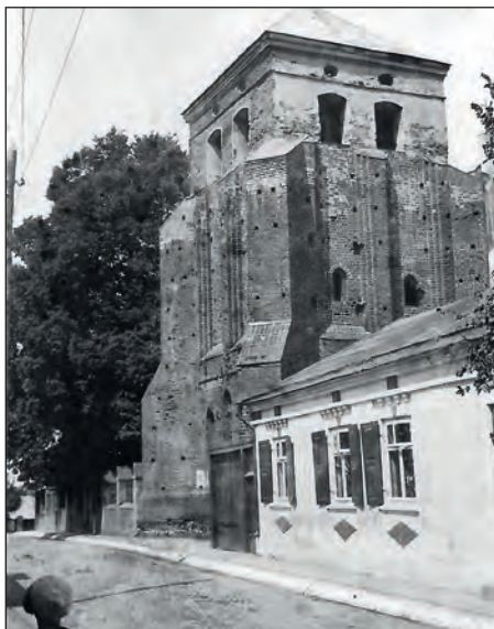
Fot. 28. Dzwonnica parafii pw. Wniebowzięcia Najświętszej Maryi Panny i św. Jakuba Apostoła w Szadku – widok od strony ul. Kościelnej, lata 30. XX w.
