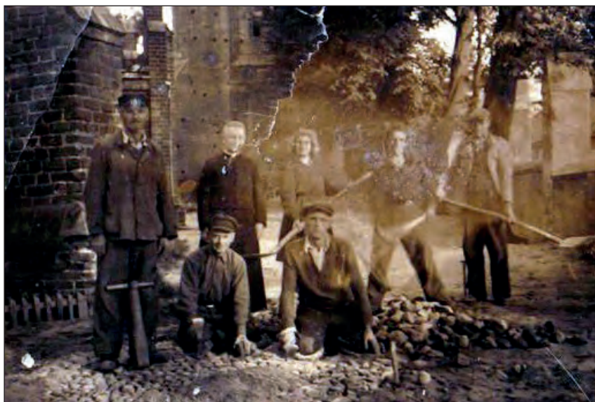
Fot. 37. Brukowanie terenu wokół kościoła pw. Wniebowzięcia Najświętszej Maryi Panny i św. Jakuba Apostoła w Szadku, lata 50. XX w. Od lewej kłęczą: Anisim Końkow i Stanisław Kłodawski. Drugi od lewej stoi ks. proboszcz Jan Wiatr
