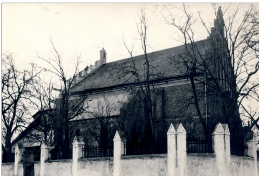
Fot. 41. Kościół pw. Wniebowzięcia Najświętszej Maryi Panny i św. Jakuba Apostoła w Szadku – widok od strony ul. Szpitalnej, lata 70. XX w.
