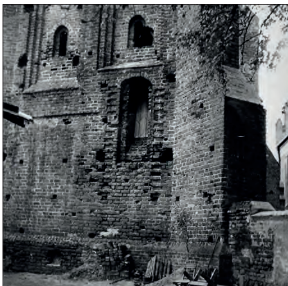
Fot. 21. Widok na fragment dzwonnicy przy kościele parafialnym pw. Wniebowzięcia Najświętszej Maryi Panny i św. Jakuba Apostoła w Szadku, ok. 1920 Źródło: ze zbiorów Wojewódzkiego Urzędu Ochrony Zabytków w Łodzi Delegatura w Sieradzu
