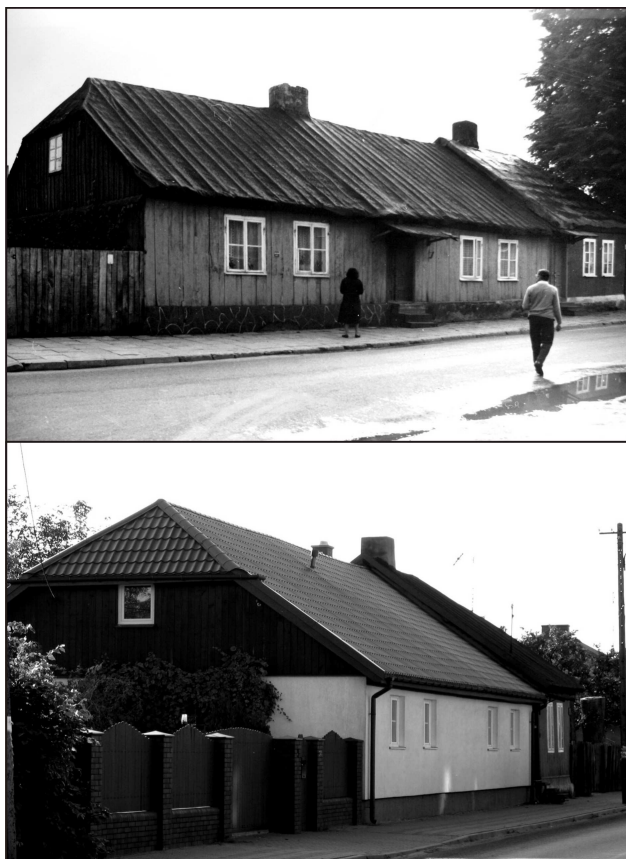
Fot. 1. Przykład zmiany fizjonomii budynku drewnianego w wyniku modernizacji, ul. Warszawska 26 (zdjęcie u góry wykonane w 1987 r., zdjęcie na dole w 2008 r.) Źródło: Ośrodek Dokumentacji Zabytków, Sieradz (zdjęcie u góry) oraz fot. autora (zdjęcie na dole)
