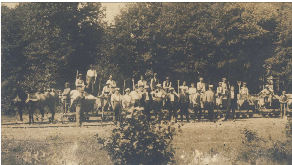
Fot. 1. Budowa linii kolejowej Herby Nowe–Gdynia na odcinku Karsznice–Szadek Źródło: ze zbiorów Teresy Szczawińskiej
