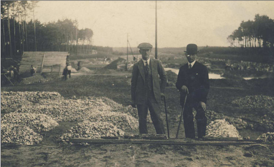
Fot. 5. Budowa linii kolejowej w okolicy Szadku, lata 30. XX w. Od lewej Czesław i Henryk Rudeccy (bracia) Źródło: ze zbiorów Krystyny Szymańskiej
