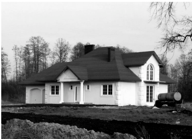
Fot. 3. Budynek w stylu dworcowym, sołectwo Szadkowice Źródło: S. Kowara, 2006
