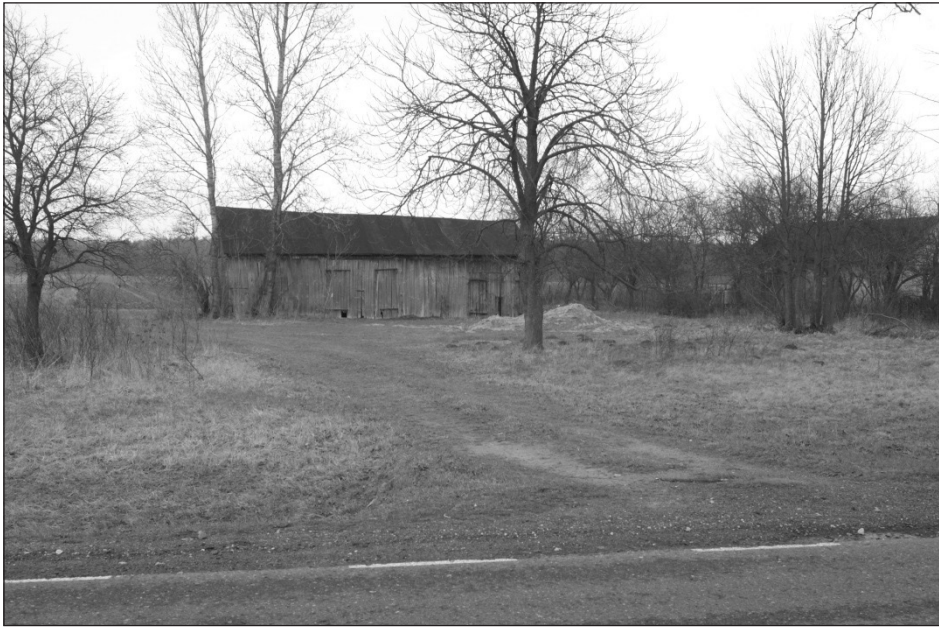
Fot. 1. Pozostałość po gospodarstwie Kazimierza Hyżego w Kotlinkach, gdzie 20 stycznia 1945 r. zatrzymał się radziecki czołg średni T-34 (stan obecny)
