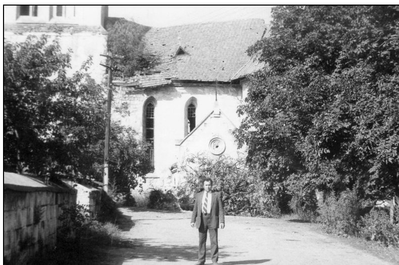
Fot. 14. Zdewastowany kościół w Podhajcach, w którym ks. M. Działarski na początku 1945 r. w zastępstwie pełnił obowiązki duszpasterskie (stan z sierpnia 1990 r., wcześniej wykorzystywany jako magazyn nawozów)
