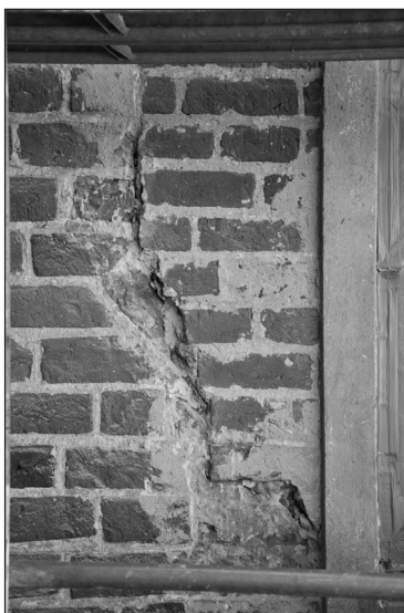
Ryc. 11. Szadek, kościół parafialny, fragment przypory korpusu widocznej we wsch. elewacji kaplicy Matki Bożej Różańcowej. Nad dolnym uskokiem przypory zachowana jedna cegła pierwotnej nakrywy Źródło: fot. Dominik Bodzioch, 2013
