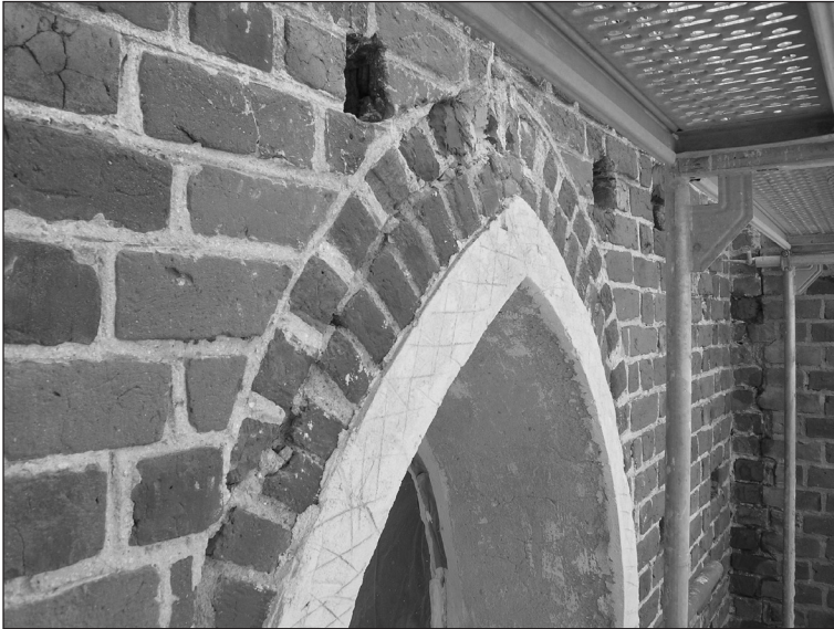
Ryc. 4. Szadek, kościół parafialny, prezbiterium, ostrołukowe zamknięcie jednego z okien. Wysklepek wykonany z cegły maszynowej. Nad nim grzbiet pierwotnego łuku z cegły palcowanej
