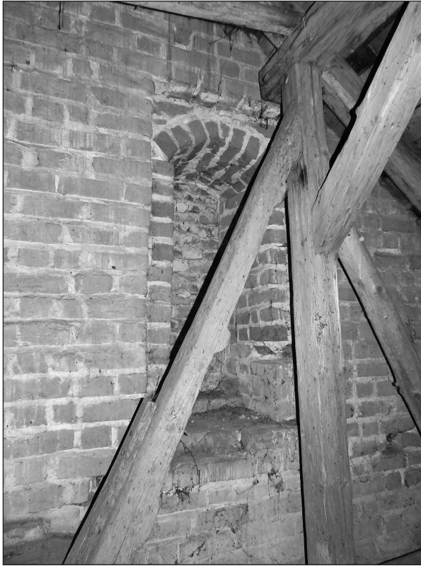
Ryc. 6. Szadek, kościół parafialny, ściana wsch. korpusu. Zamurowany otwór komunikacyjny do nawy pñ. widoczny na poddaszu, powyżej sklepienia nad skarbcem. Otwór in situ , wykonany w trakcie budowy pierwszego korpusu Źródło: fot. Stanisław Cechosz, 2012
