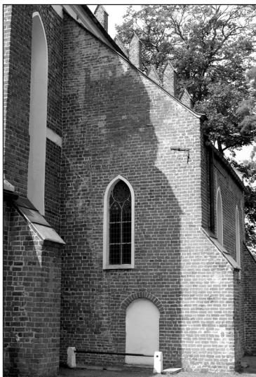
Ryc. 22. Szadek, kościół parafialny, wsch. elewacja kaplicy Matki Bożej Różańcowej z ostrołukowym oknem i zamurowanym wejściem. Stan przed konserwacją Źródło: fot. Stanisław Cechosz, 2009
