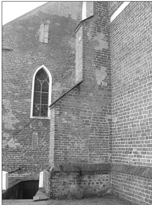
Ryc. 24. Szadek, kościół parafialny, zach. elewacja kaplicy Matki Bożej Różańcowej i przedostatnia przypora korpusu kościoła. W jej ścianie zach. zarys zamurowanego wejścia na piętro kaplicy. Stan przed konserwacją Źródło: fot. Stanisław Cechosz, 2009
