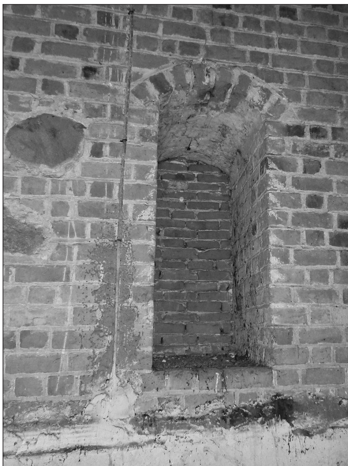
Ryc. 5. Szadek, kościół parafialny, płn. ściana prezbiterium. Zamurowane i wysoko umieszczone wejście do prezbiterium, widoczne na poddaszu zakrystii i skarbcza
