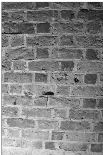
Ryc. 19. Szadek, kościół parafialny, pln. elewacja korpusu, trzecie przeszło od wsch. Górna część ściany widoczna na poddaszu kaplicy, powyżej wgłębego fryzu. Lico ściany opracowane w wątku gotyckim. Spoina trójkątnie wybrzuszona, z nacięciem na fugach pionowych
