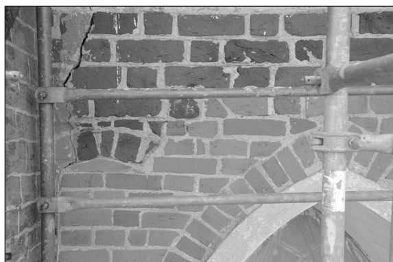
Ryc. 20. Szadek, pln. elewacja korpusu, trzecie przeszło od wsch. Ostrołukowe zamknięcie istniejącego okna wykonane z cegły maszynowej. Po lewej, tuż przy zach. elewacji kaplicy, cztery cegły ostrołukowego zamknięcia okna kościoła halowego. Ta sama substancja w górnej części muru
