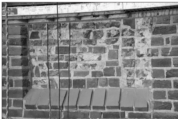
Ryc. 13. Szadek, kościół parafialny, płn. elewacja korpusu, przęsło wsch. Rozglifione i otynkowane ościeże pierwotnego okna odsłonięte w tle wnęki pod parapetem obecnego otworu
