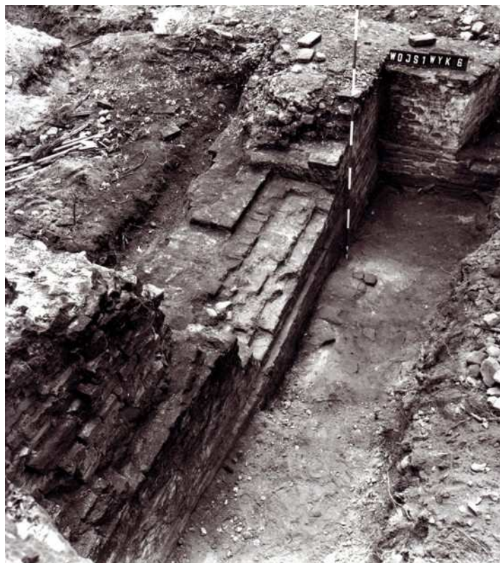
Fot. 3. Wykop nr 6: relikty ściany działowej między pomieszczeniami „A” i „B” zameczku w Wojsławicach
