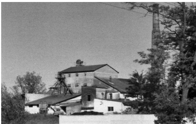
Fot. 1. Prusinowice. Dawny młyn elektryczny w kompleksie gorzelnicznym Źródło: R. Kucharski, Młyny jako element zagospodarowania ...
