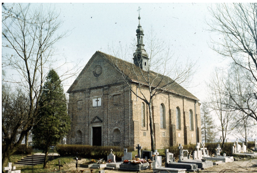
Fot. 10. Kościół św. Idziego w Szadku – widok od strony płd.-zach., 1986 r.
