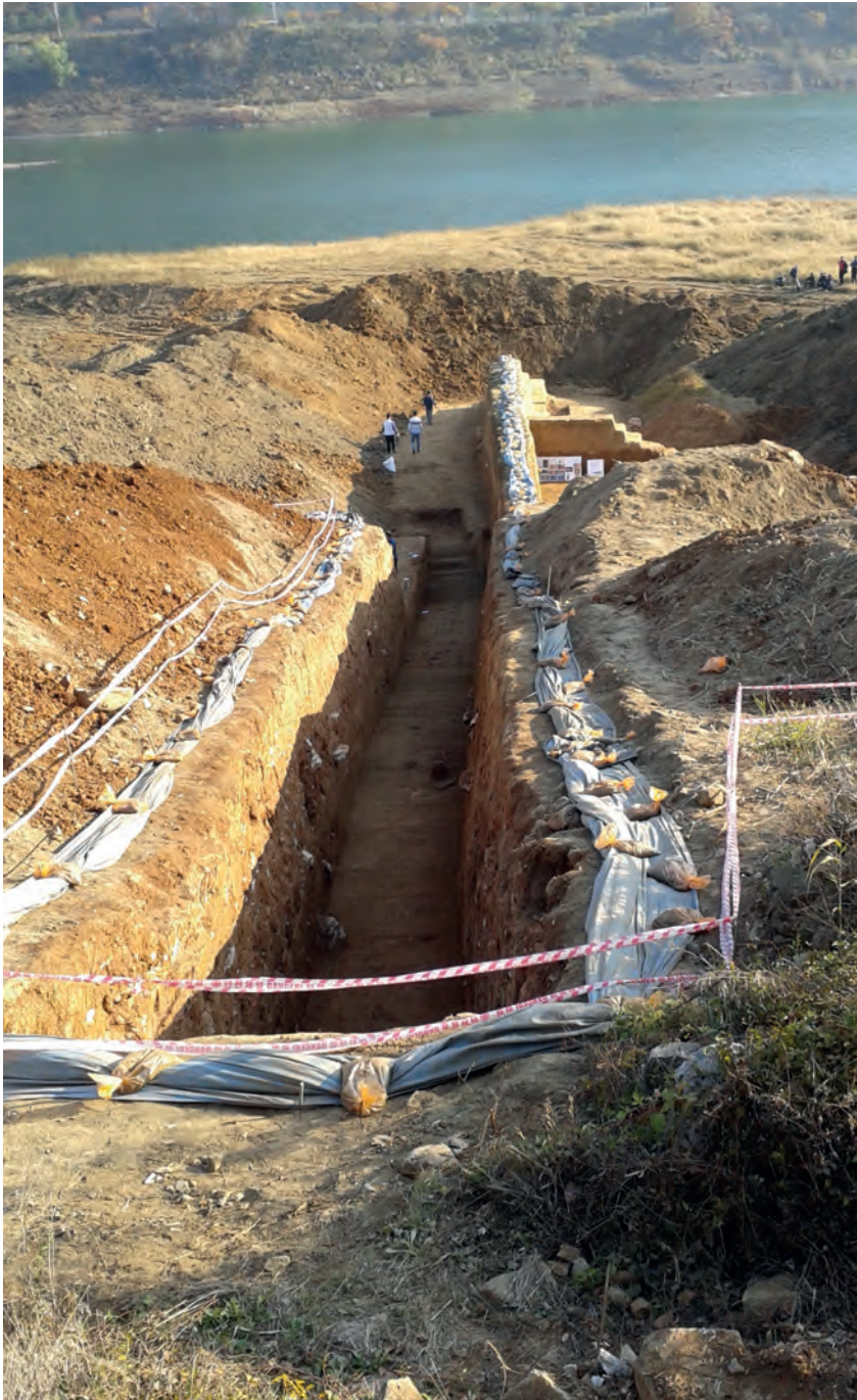
Ryc. 17. Wykop 5D na stanowisku Suyanggae VI (fot. M. Bartczak).
