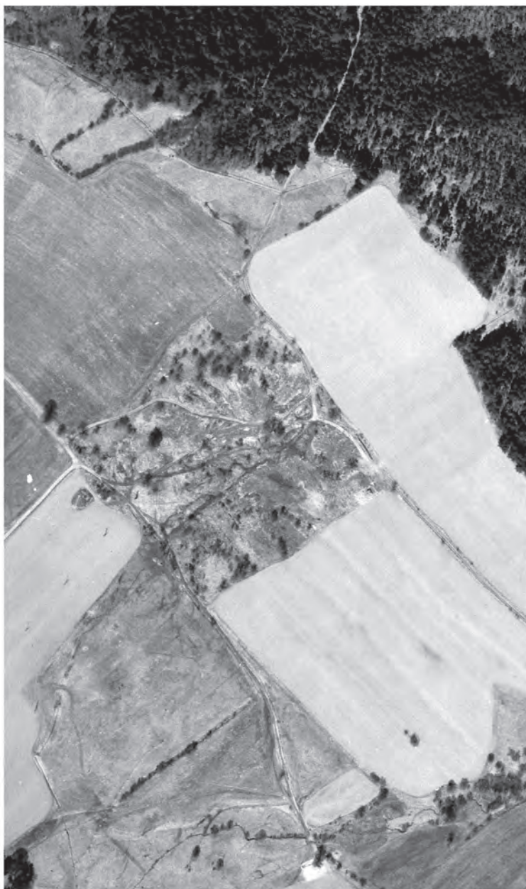
Obr. 5. Polžov (Pilsenschlag), k. ú. Lužnice: letecký snímek úplně destruované vesnice z roku 1967 (VGHMÚř, letecký měřičský snímek 02076/1967).
