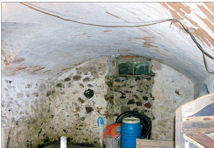
Ryc. 4. Dwór w Górkach Małych – piwnica – mniejsze pomieszczenie.
