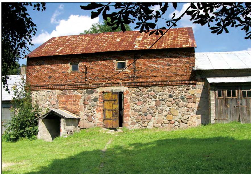
Ryc. 1. Dwór w Górkach Małych – elewacja południowa.
