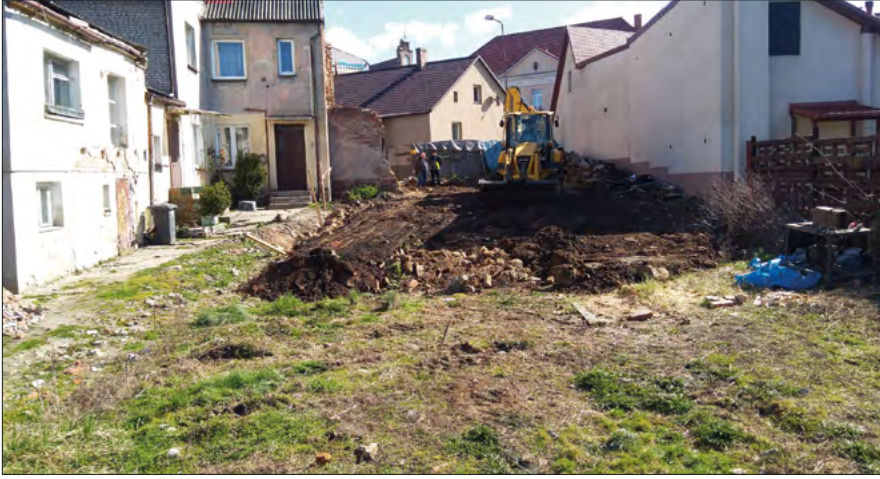
Ryc. 5. Widok ogólny działki I od strony ul. Rzeczej w momencie rozpoczęcia robót ziemnych (fot. P. Banaszak).
