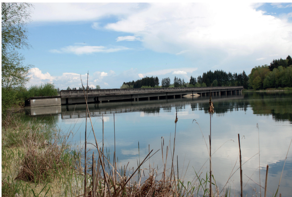
Obr. 9. Opuštěný dálniční most přes Sedlický potok je dnes téměř celý zaplaven vodní nádrží Želivka (foto J. Pařez, květen 2017).
