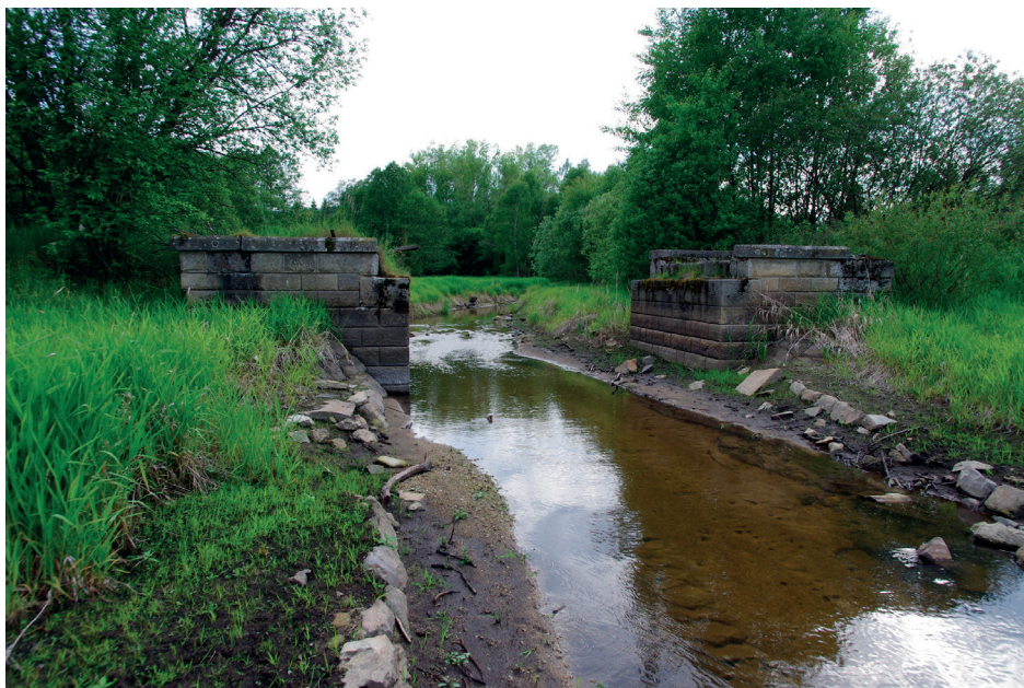
Obr. 7. Most přes Smrčinský potok. Pohled ze severovýchodu (foto L. Funk, červen 2014).
