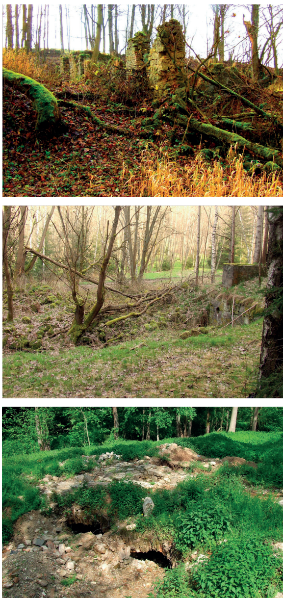
Obr. 5. Celkové pohledy na pozůstatky staveb vodních mlýnů. Vlevo nahoře Mašův mlýn, pohled od severu, v popředí mlýnice. Vpravo nahoře Francův mlýn, pohled od jihovýchodu, v pravé části betonová kašna na turbínu a relikty mlýnice. Konvexní útvar v levé části skrývá zbytky nejmladšího topeniště (okres Tachov). Dolní fotografie přibližuje pozůstatky touchořinského mlýna, pohled od západu. V popředí mlýnice, v pozadí síň (okres Litoměřice) (foto L. Galusová 2008 – Mašův a Francův mlýn a 2012 – Touchořiny).
