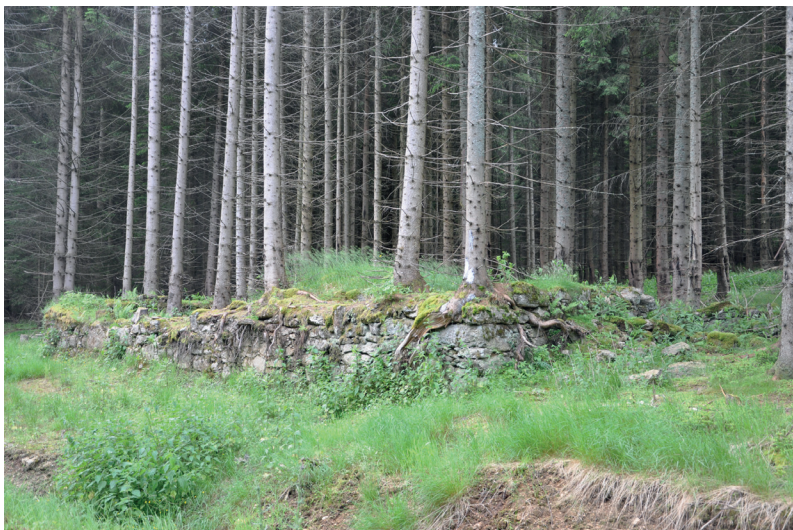
Obr. 7. Staré Šance (Schanz), k. ú. Pohoří na Šumavě: domy podél dálkové cesty do Freistadtu vesměs zanikly jednorázovou částečnou destrukcí a reliktů se dodnes zachovaly do výše nejméně metr nad současný povrch (foto M. Bureš, květen 2010).
