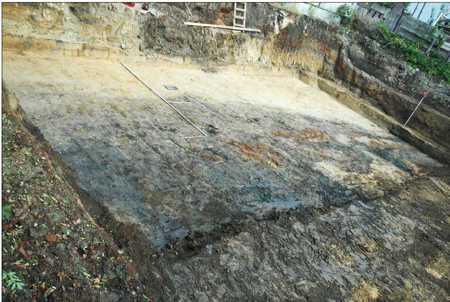
Ryc. 4. Ulica Sienkiewicza, zdjęcie wykopu od strony zachodniej z zarysem fosy.
