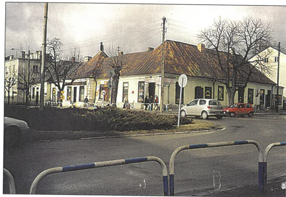
Fot. 19. Królewski pałac podróżny przed pożarem fot. P. Filipowicz
