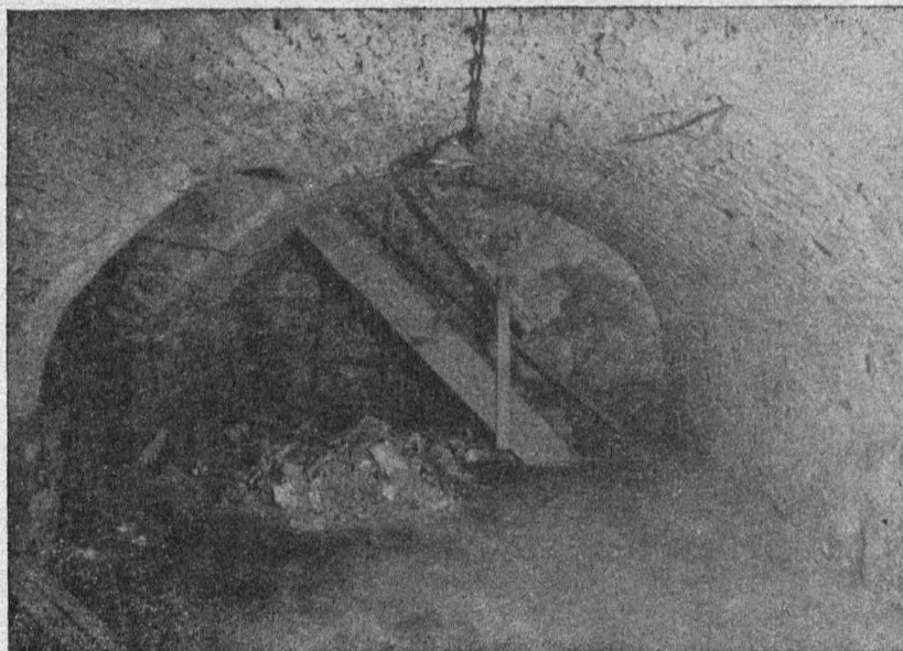
Fot. 4. Ostromecko, „pałac stary”, relikw muru starszego dworu w ścianie szczytowej pomieszczenia piwnicznego nr I. Sklepienie kolebkowe z XVIII w. Fot. M. Sowińska, nr 6488/14/1976
